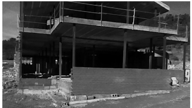
Foto: Presunta rehabilitación en La Maileza. Titaguas.
